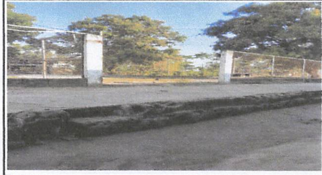
Foto 2: Reparación de gradas de ingreso
