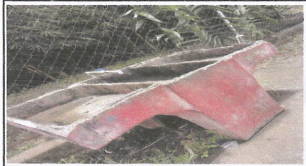
Foto 2: Reparación de pila para lavamanos
