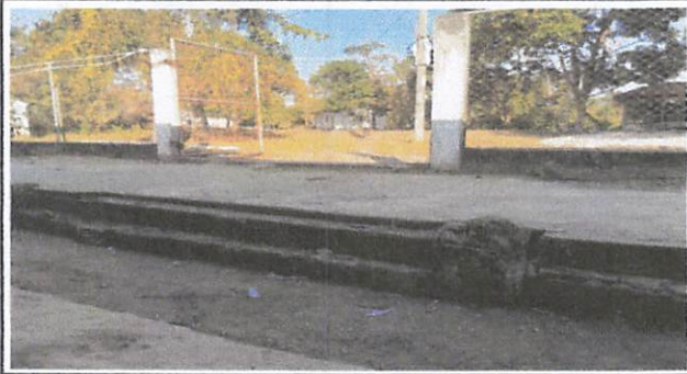
Foto 1: Reparación de porton y colocación de banda caida.
