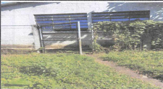
Foto 3: Reparación de porton de ingreso posterior
