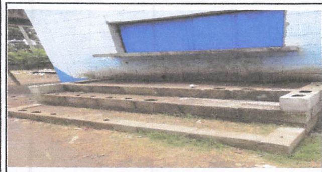
Foto 3: Reparación de gradas para recibir alimentos
