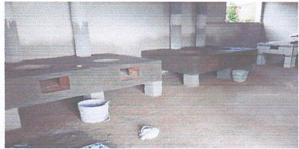
Foto 4: poyos de cocina nuevos
