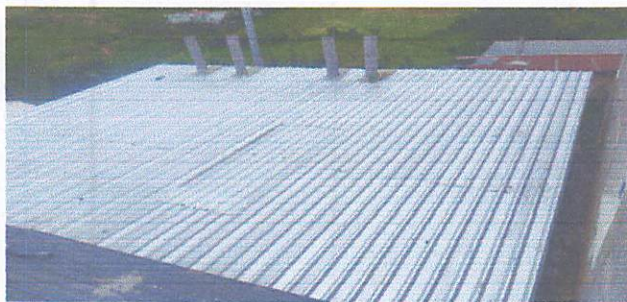
Foto 5: nuevo techo de cocina
