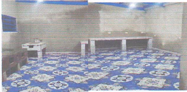
Foto1: Ampliación de cocina.
