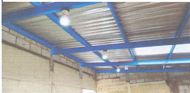
Foto 6: costaneras y techo nuevo
