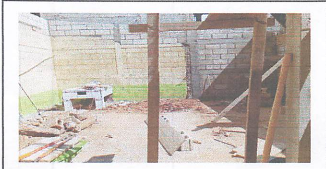
Foto 1: ampliación de cocina
