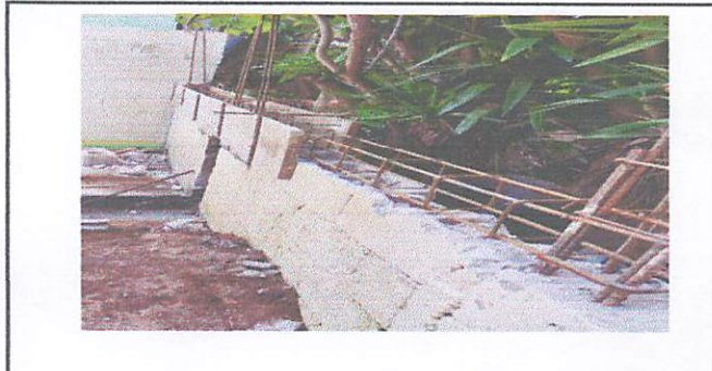
Foto 2: construcción de pared para escenario
