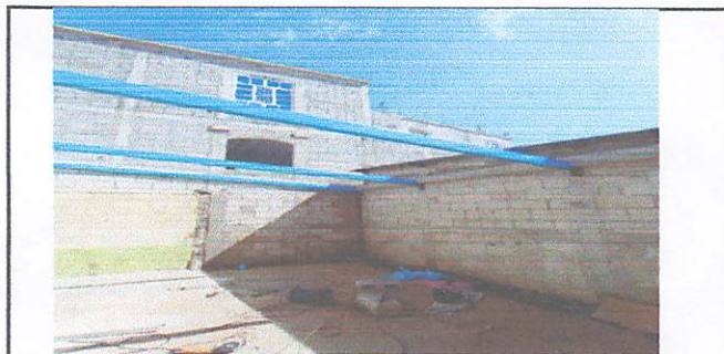
Foto 6: vigas para techado nuevo de la cocina
