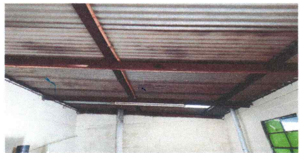
Foto 6: vigas de madera ya deteriorada e instalación electrica con lamparas quemadas y sin funcionamiento
