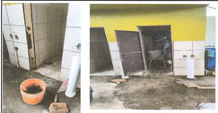
Foto 4: AREA EN PROCESO DE BAÑO/DESTITUIR CERNIDO VIEJO POR NUEVO TRES BAÑOS
