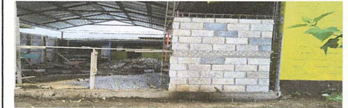
Foto 2: AREA EN PROCESO DE RECONSTRUCCION DE LA PARED
