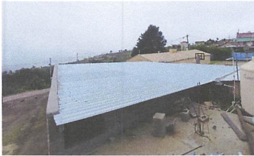
Foto1: Techo de cocina nuevo
