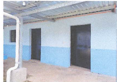
Foto 6: Pintado de pared del exterior de cocina y pintado de las 2 puertas
