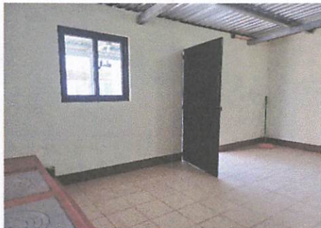
Foto 5: Cambio de ventana, colocacion de piso y pintado de paredes interno de paredes de cocina nueva
