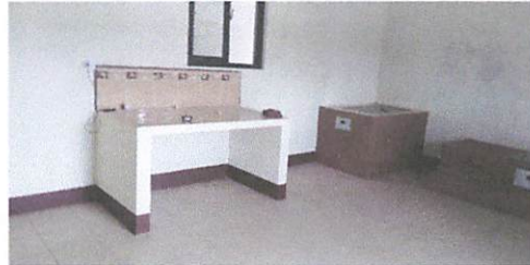
Foto 2: Ventana nueva, mesa de concreto y poyo normal
