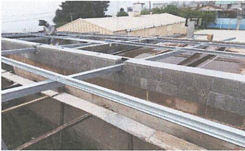
Foto 3: Colocacion de estructura del techo de la cocina
