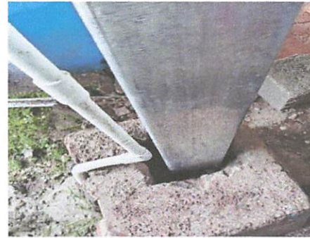
Foto 4: Cambio de tuberia de agua potable
