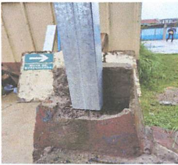
Foto 3: Reparacion de bases para parales
