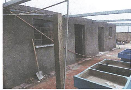
Foto 2: colocacion de estructura para el techo del corredor
