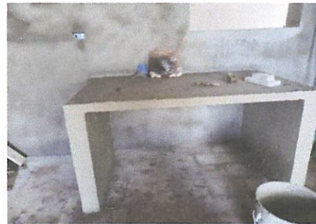
Foto 6: Construccion de mesa de concreto
