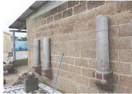
Foto 2: Instalacion de chimenea para que salga el humo que resulta al momento de cocinar
