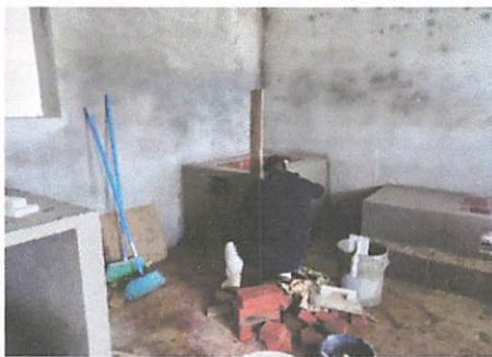
Foto 5: Construccion de poyeton para peroles y poyo normal
