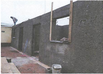
Foto 1: Tallado de pared, adentro y afuera de la cocina
