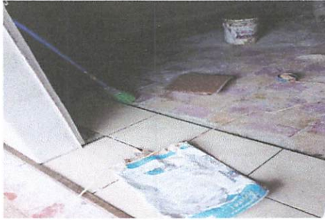
Foto1: Colocacion de piso en la cocina
