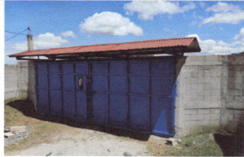
Foto 2: Techo reparado del portón.
