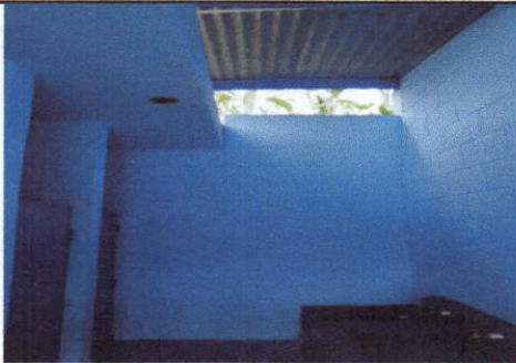
Foto 3: Puertas de sanitarios y aulas con mantenimiento.
