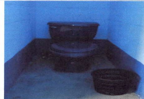
Foto 6: Sanitarios nuevos instalados.
