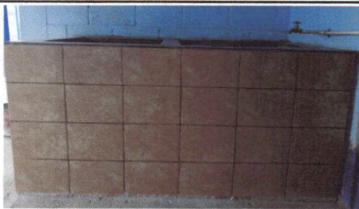
Foto 5: Pila de concreto con azulejo
