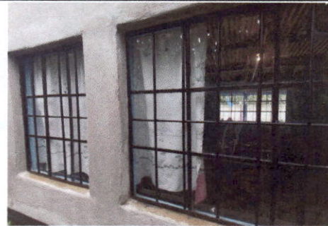
Foto 4: Ventanas y balcones con mantenimiento.
