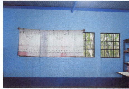
Foto 2: Paredes libres de humedad.
