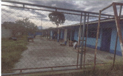
Foto 3: Mantenimiento a malla perimetral.
