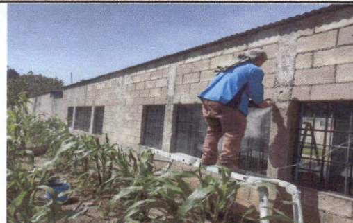
Foto 2: Repello en paredes de exterior.
