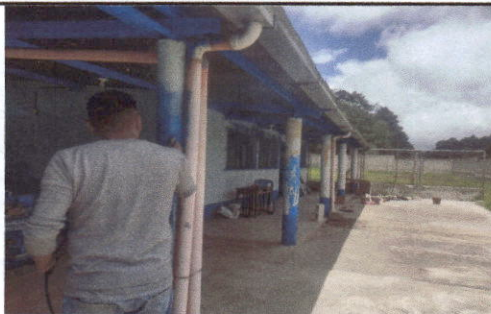
Foto 5: Suministro de pintura de todas las paredes.
