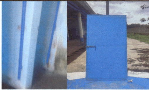
Foto 3: Desinstalación de puertas para suministro de pintura.
