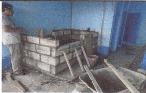
Foto 5: Construcción de pila de concreto.
