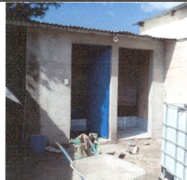
Foto 6: Terminación de ampliaciones de sanitarios.
