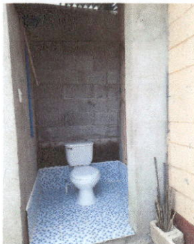
Foto 5: Terminación de ampliación de sanitario.
