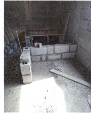
Foto 2: En proceso construcción de poyos.
