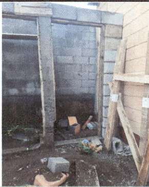
Foto 5: En proceso ampliación de sanitario.
