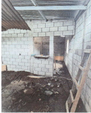
Foto 1: En proceso terminación de pared.
