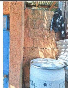
Foto 6: Espacio para colocar otro sanitario.
