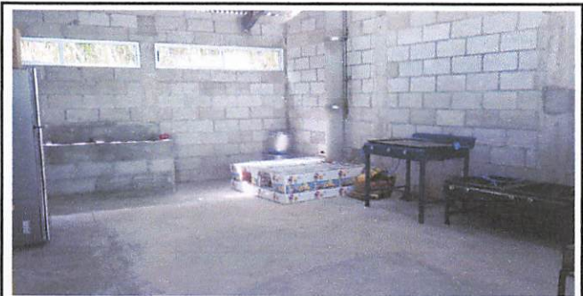
Foto 6: Interior cocina actual.
