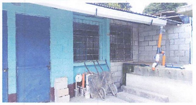
Foto1: Fachada, cocina y canal actual.
