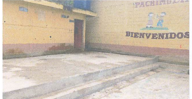
Foto 4: Colocación piso rustico
