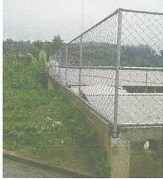
Foto 1: Colocación de Malla Perimetral
