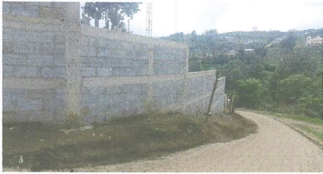
Foto 1: Construcción de muro perimetral
