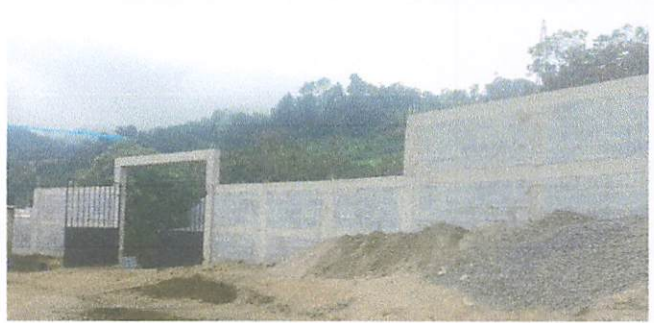
Foto 2: Construcción muro perimetral
