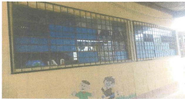
Foto 5: Colocación de balcones
