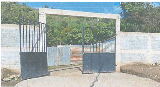
Foto 3: Colocación de Porton
