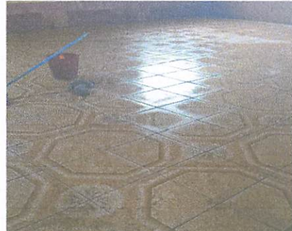
Foto 6: Colocación piso ceramico
