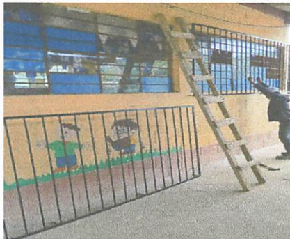
Foto 5: Colocación de balcones
