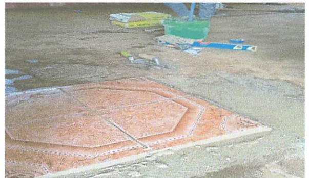
Foto 6: Colocación piso ceramico
