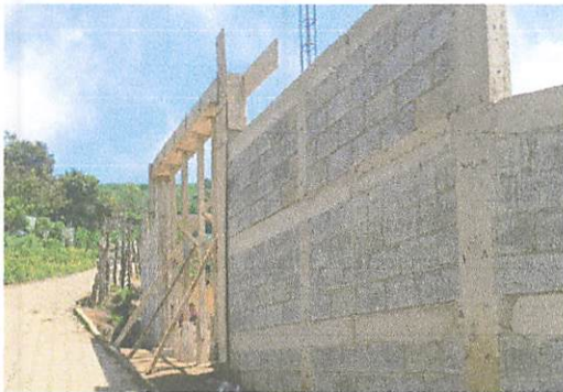
Foto 3: Colocación de Porton
