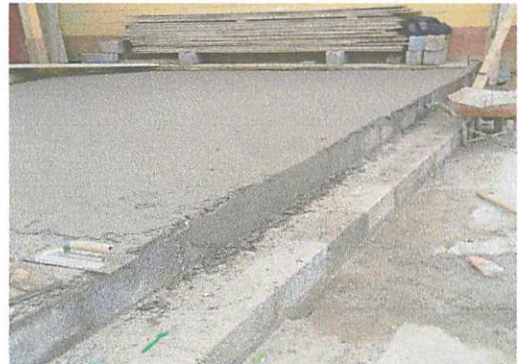
Foto 4: Colocación piso rustico
