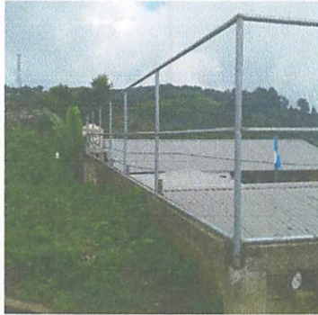
Foto 1: Colocación de Malla Perimetral
