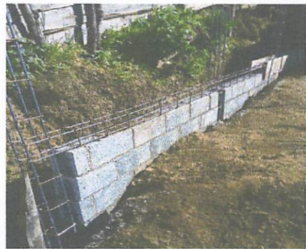
Foto 2: Construcción muro perimetral
