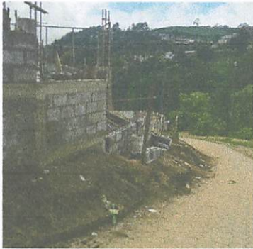
Foto 1: Construcción de muro perimetral
