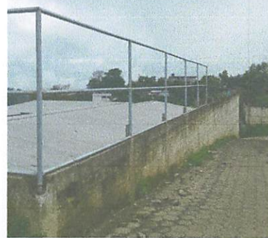
Foto 2: Colocación de Malla Perimetral
