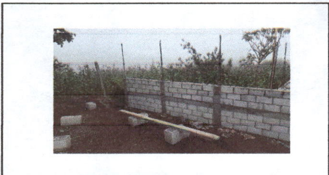
Foto 4: MURO DE CONTENCIÓN
