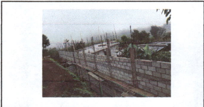
Foto 2: MURO DE CONTENCIÓN
