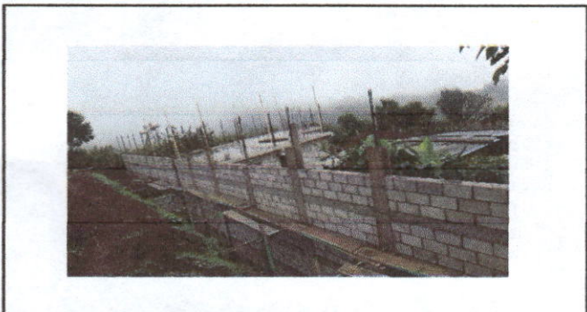
Foto 3: MURO DE CONTENCIÓN
