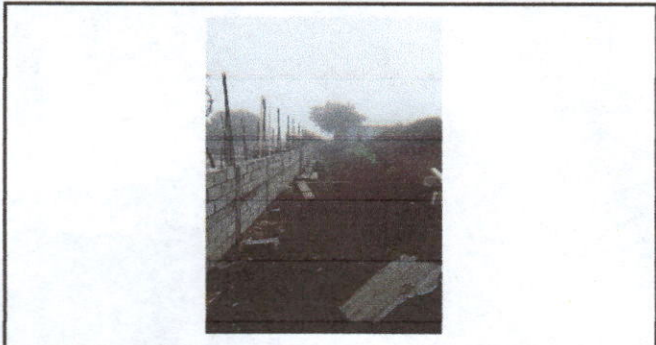
Foto1: MURO DE CONTENCIÓN
