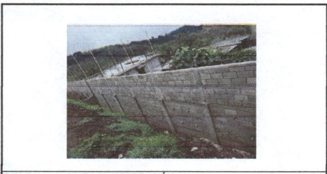
Foto 5: MURO DE CONTENCIÓN
