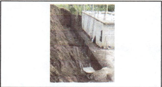
Foto 4: MURO DE CONTENCIÓN
