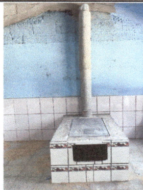
Foto 8: NUEVA PLANCHA DE METAL
