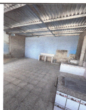
Foto 6: CAMBIO DE TECHADO
