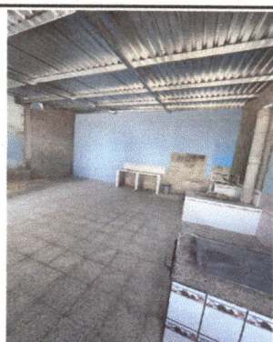
Foto 3: AMPLIACIÓN DE COCINA
