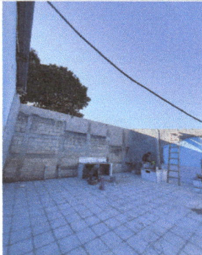
Foto 3: AMPLIACIÓN DE COCINA
