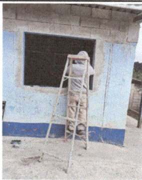
Foto 11: COLOCACIÓN DE VENTANAS
