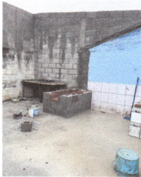
Foto 5: DEMOLICIÓN DEL MURO
