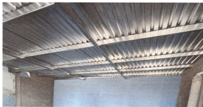
Foto 10: AMPLIACIÓN DE TECHO
