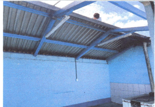
Foto 6: CAMBIO DE TECHADO
