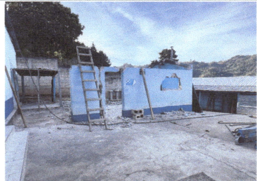
Foto 4: COCINA DURANTE LA CONSTRUCCIÓN
