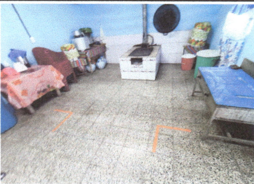
Foto 9: ÁREA DONDE SE AGREGARÁ MAS PISO
