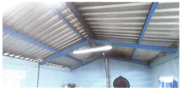
Foto 10: AMPLIACIÓN DE TECHO
