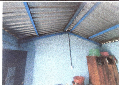
Foto 6: CAMBIO DE TECHADO
