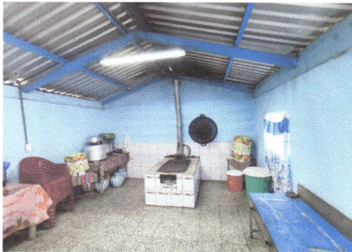
Foto 3: ES NECESARIO AMPLIAR LA COCINA
