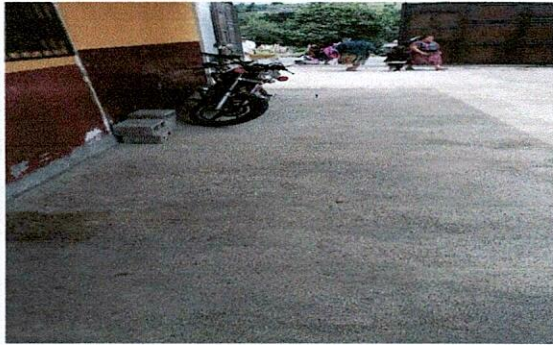
Foto1: Construcción del Cisterna
