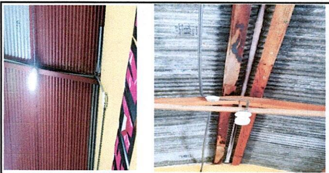
Foto 6: Cambio de clavos y tornillos en láminas
