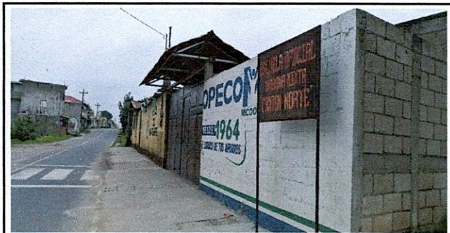
Foto 5: Repello y cernido de la pared de la calle
