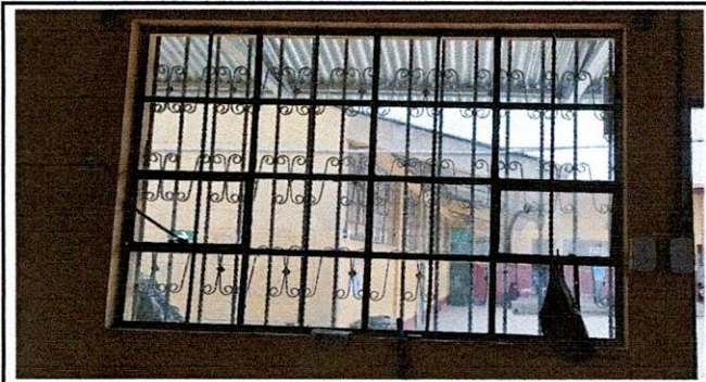
Foto 2: Ventanas corredizas con malla metálica
