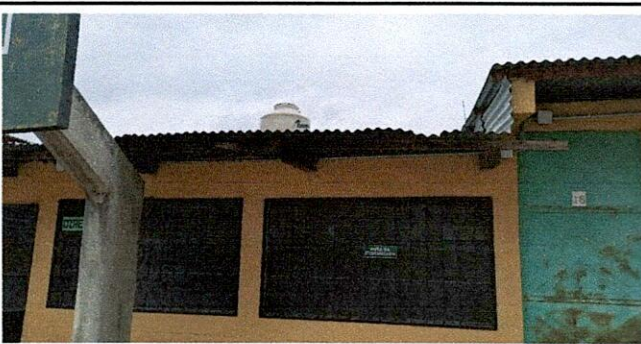
Foto 5: Reemplazar clavos y tornillos sin empaques en aulas y dirección
