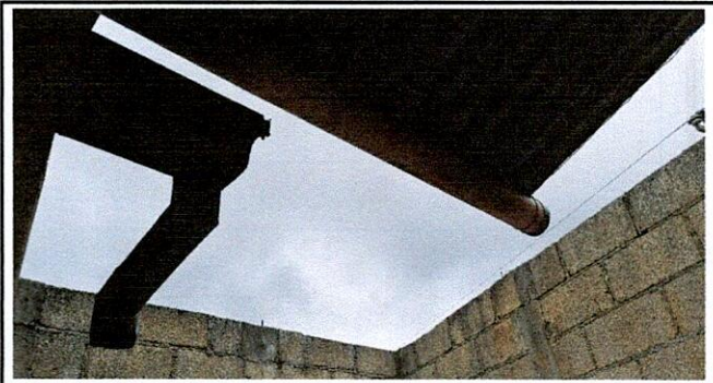
Foto 2: Colocación de techo con lamiluz sobre las pilas
