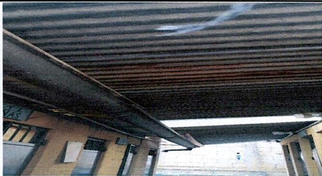
Foto 1: Cambio de techado de sanitarios de niños y niñas
