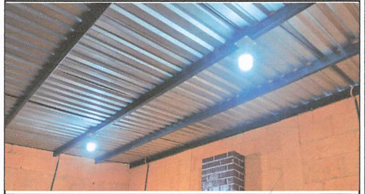
Foto 2: Remodelación de techo de cocina
