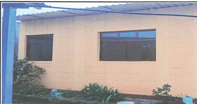
Foto 3: Cambio de ventana
