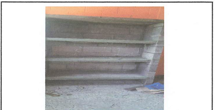
Foto 6: Remodelación de la cocina con trinchante de cemento
