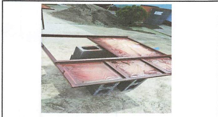
Foto 3: Cambio de ventana
