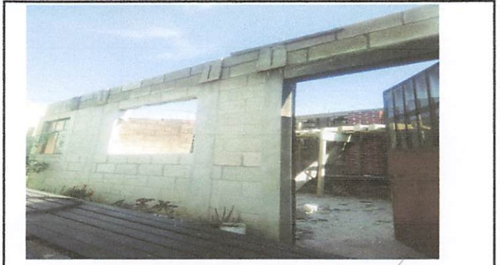
Foto 2: Remodelación de techo de cocina
