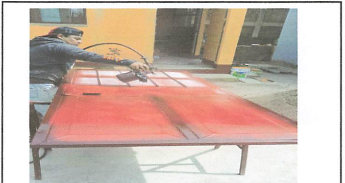
Foto 4: Remodelación de puerta
