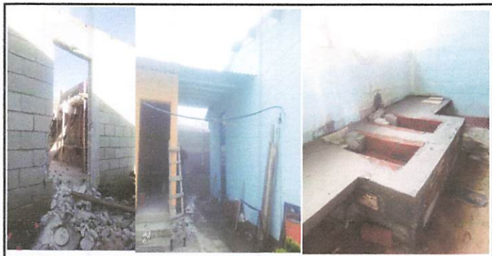
Foto 5: Apertura de puerta, techado, tallado de baño y pollera
