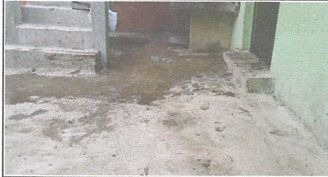
Foto 8: Conexión de tubo y drenaje realizado
