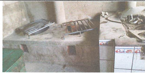
Foto 14: finalización de los poyos bajos
