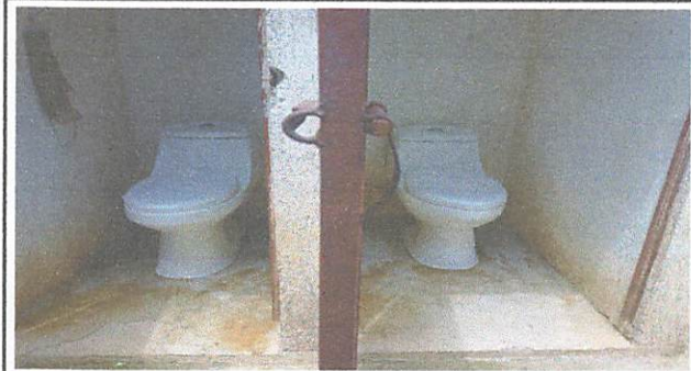
Foto 10: Inodoros nuevos instalados
