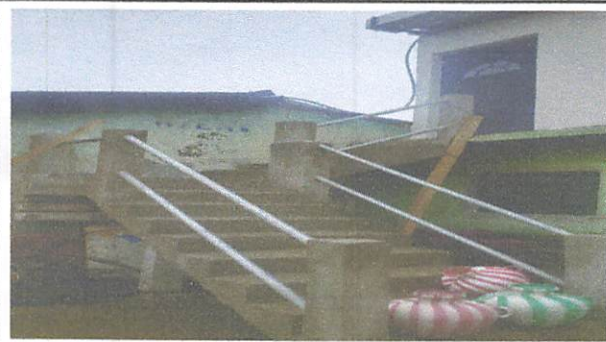
Foto 15: finalización de muñecos y concretos y pasamanos
