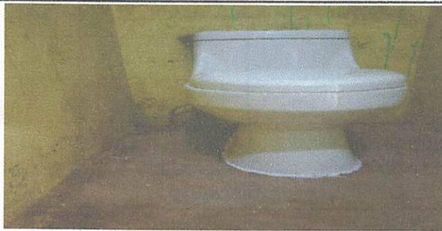
Foto 9: inodoros nuevos instalados
