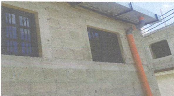
Foto 5: ventanas por terminar
