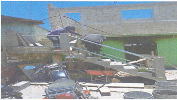
Foto 15: avance pasamanos y muñecos de concreto
