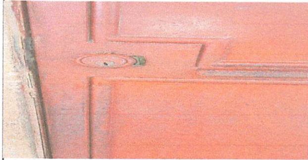
Foto 2: cambio de chapa
