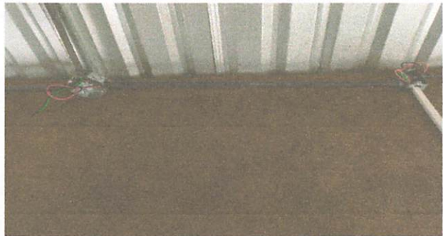
Foto 16: avance de la instalación eléctrica
