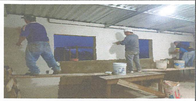
Foto 12: Inicio del cernido con cemento y monocapa
