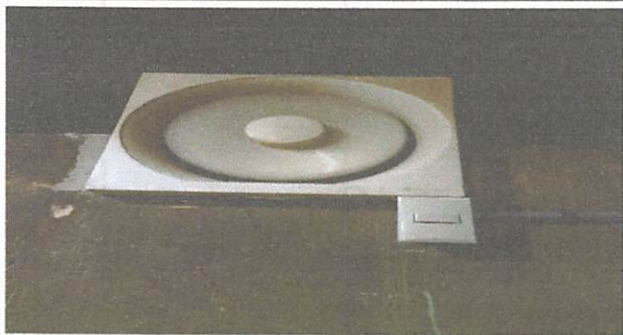
Foto 11: colocación de extractor de humo
