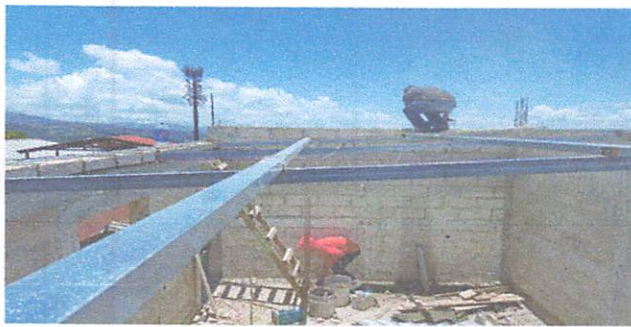
Foto 3: Inicio de techado
