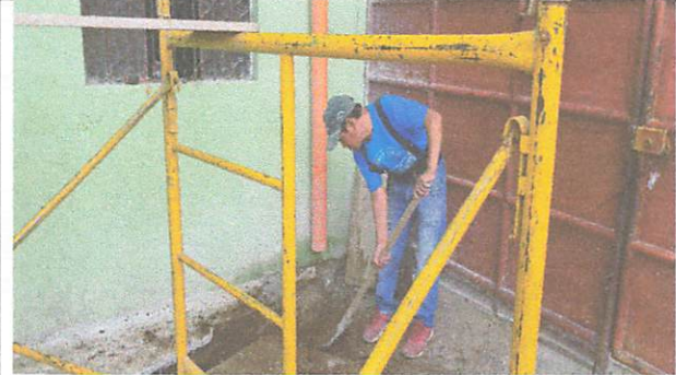
Foto 8: Inicio de tubo y drenaje
