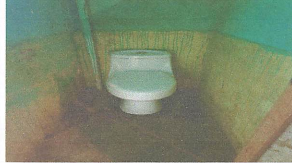
Foto 10: Inicio de instalación de inodoros
