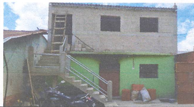
Foto 4: Instalación de puertas
