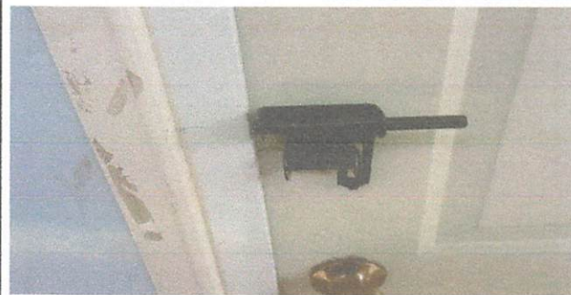
Foto 6: chapa por colocar
