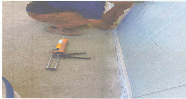
Foto 7: Inicio de impermeabilizante
