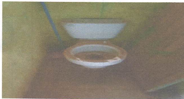
Foto 9: Suministro e instalación de inodoros
