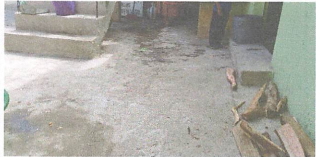
Foto 8: Conexión de tubo y denaje
