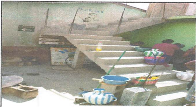
Foto 15: Pasa manos tubo 2" galvanizado y muñecos de concreto
