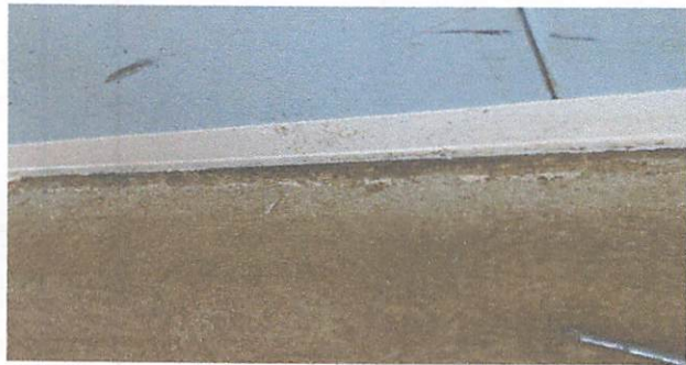
Foto 7: Impermeabilizable de salón
