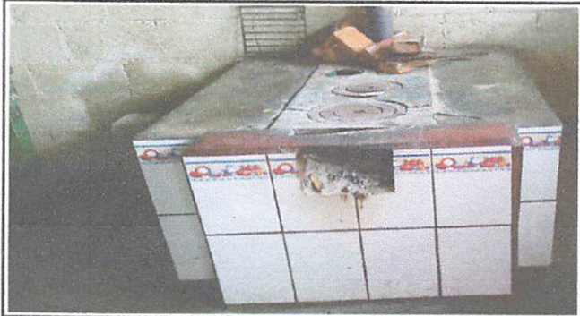
Foto 14: Realización de poyos bajos
