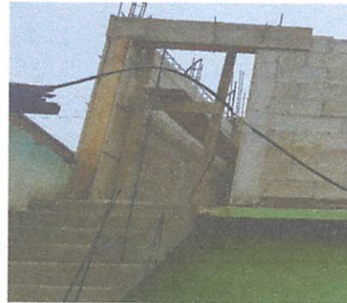
Foto 4: Instalación de puerta
