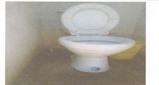
Foto 10: Suministro e instalación de inodoros
