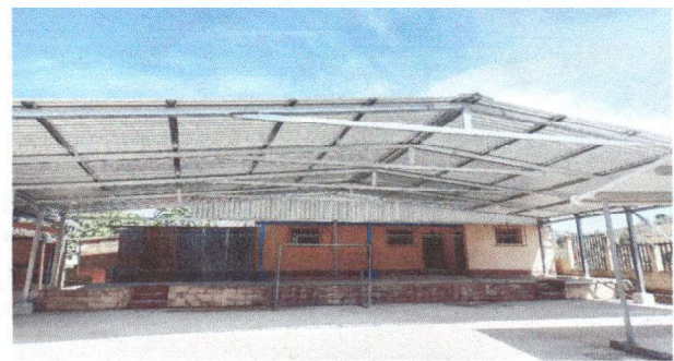
Foto 6: Sustitución de techado 130m2
