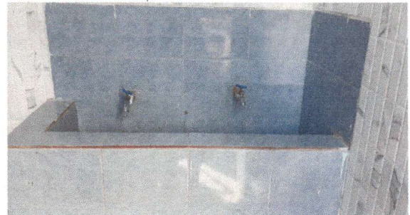
Foto 4: arreglo de chorros en lavamanos sanitario varones
