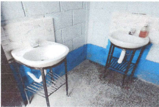
Foto 3: Cambio de lavamanos en sanitario de niñas
