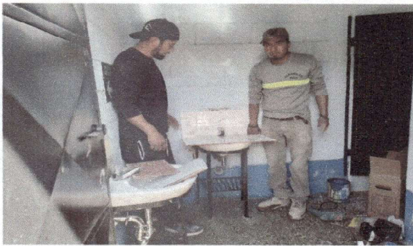
Foto 3: Cambio de lavamanos en sanitario de niñas
