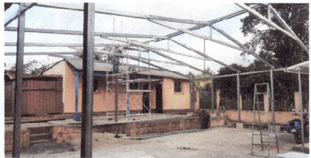
Foto 6: Sustitución de techado 130m2
