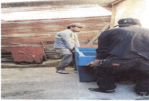
Foto 7: cambio de pila
