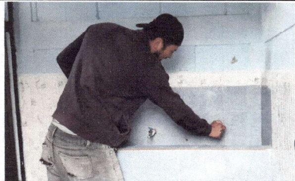
Foto 4: arreglo de chorros en lavamanos sanitario varones
