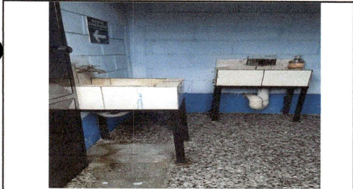
Foto 3: Cambio de lavamanos en sanitario de niñas
