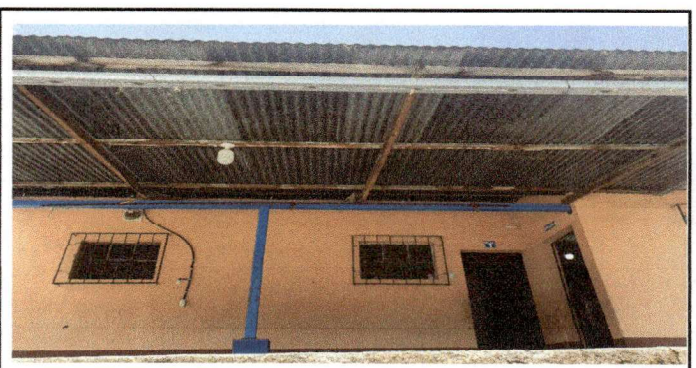
Foto 6: Sustitución de techado 130m2
