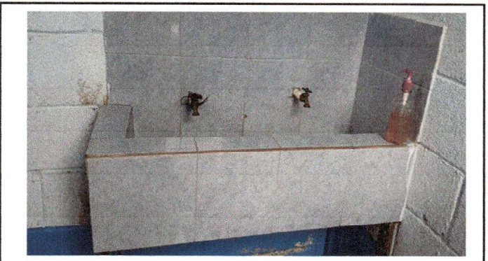
Foto 4: arreglo de chorros en lavamanos sanitario varones
