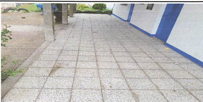
Foto 5: Cambio de piso de torta a piso de granito en corredor de la cocina.
