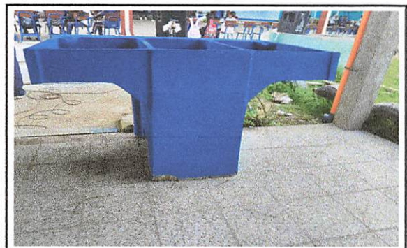
Foto 10: Cambio de pila y construcción de caja, cambio de tubo de cemento por tubo pvc de drenaje de la cocina.
