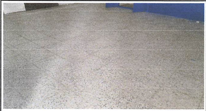
Foto 4: Cambio del piso de la cocina, por piso tipo granito.
