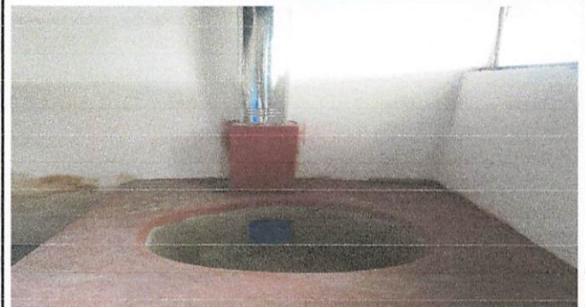
Foto 2: Construcción de 3 poyos con sus respectivas chimeneas y extractores de humo.
