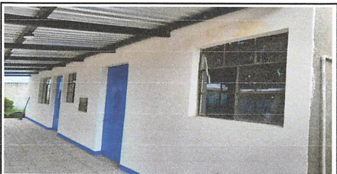
Foto 6: Repello de paredes del interior y exterior de la cocina.
