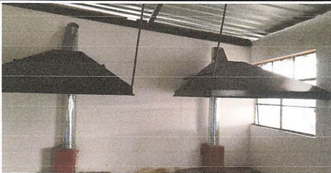
Foto 3: Construcción de 3 chimeneas de metal con sus respectivos extractores de humo.
