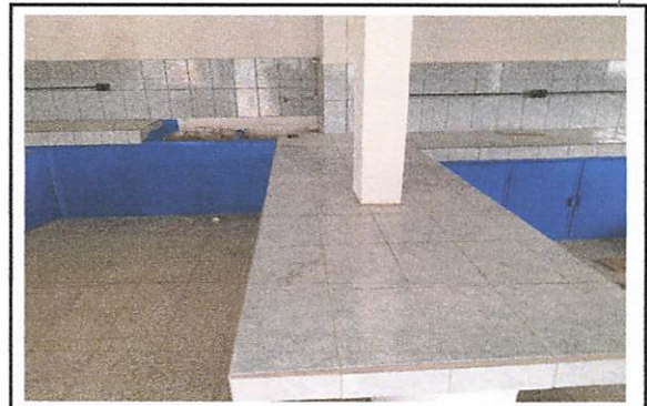
Foto 8: Cambio de azulejo de pila y desayunador en la cocina.
