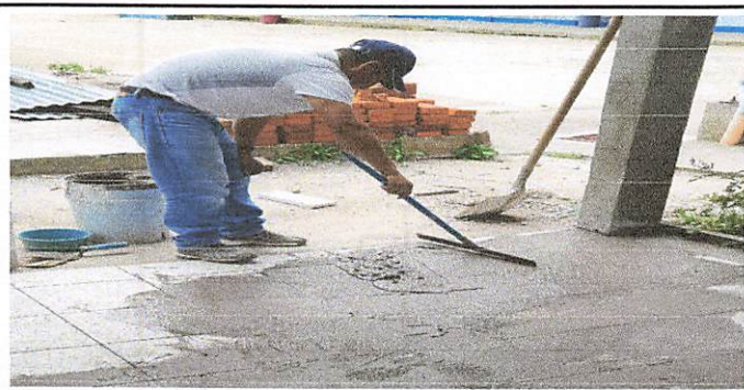
Foto 5: Cambio de piso de torta a piso de granito en corredor de la cocina.
