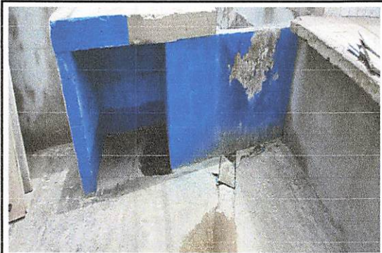
Foto 7: Construcción de gabinetes con puertas de metal en la cocina.
