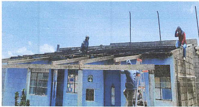
Foto 1: Cambio de láminas y costaneras de metal para techo de cocina y sistema eléctrico.
