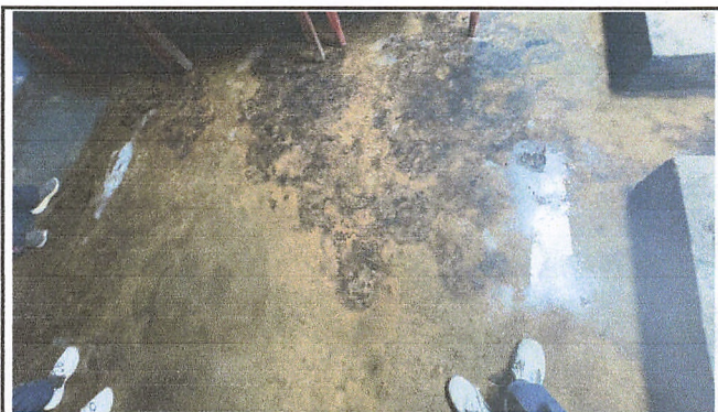
Foto 4: Cambio del piso de la cocina, por piso tipo granito.
