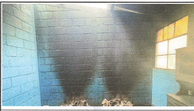
Foto 6: Repello de paredes del interior y exterior de la cocina.
