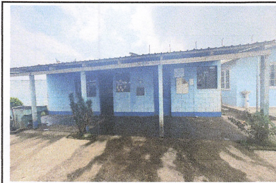
Foto 9: Cambio de postes de cemento por columnas de concreto de corredor de cocina, canales y pescantes con bajada.
