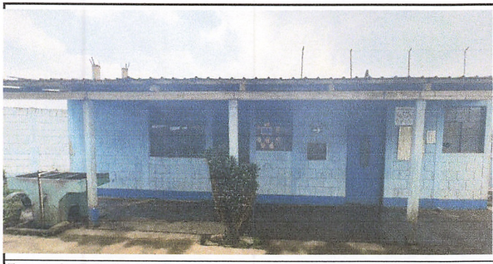
Foto 5: Cambio de piso de torta a piso de granito en corredor de la cocina.
