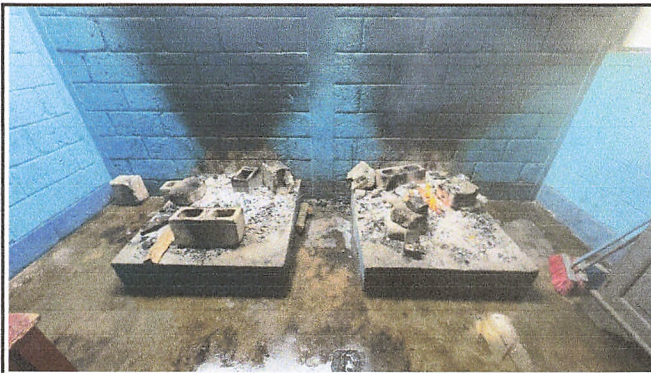
Foto 2: Construcción de 3 poyos con sus respectivas chimeneas y extractores de humo.
