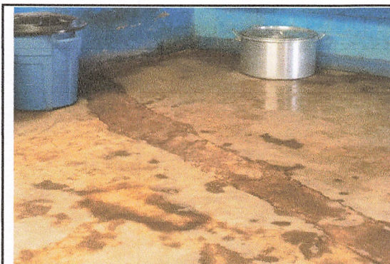
Foto 11: construcción de caja y remodelación de tubería de cemento de drenaje por tubería pvc.
