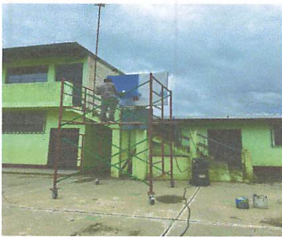
Foto 5: Durante los trabajos de reparación de los tableros
