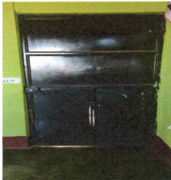
Foto 8: Cambio de chapa de una puerta
