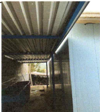
Foto 9: colocación de una lamina sobre el techo para que el agua no entre en la cocina
