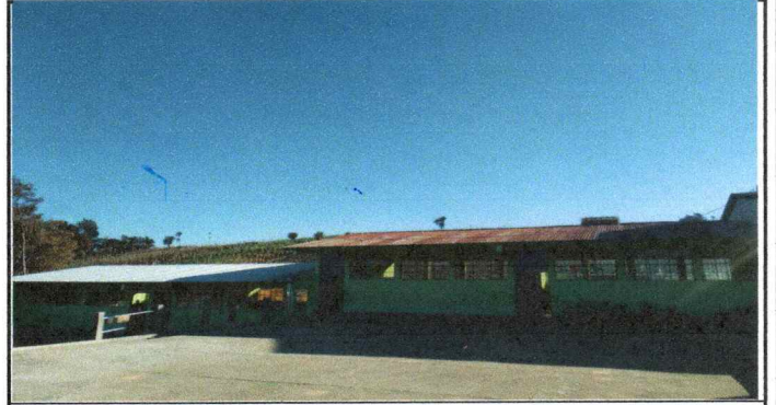
Foto 6: cambio de tehado de 4 salones visto por fuera
