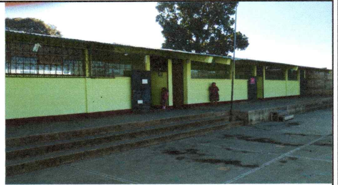
Foto 2: Colocación de canales y bajadas de agua fente 10 salones
