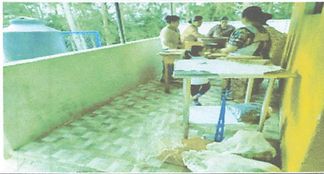
Foto 1: ESPACIO ANEXO CON PISO INSTALADO
