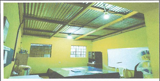
Foto 6: SALA DE MAESTRO ILUMINADA
