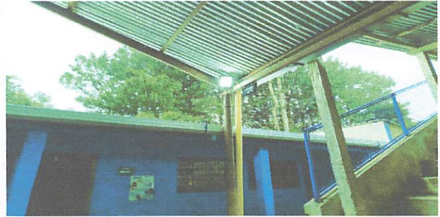
Foto 2: REFLECTORES EN CANCHA
