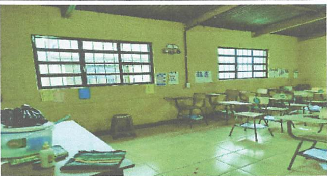
Foto 3: AULA 3 VENTANAS NUEVAS CORREDIZAS INSTALADAS
