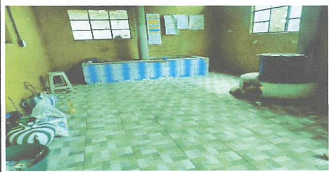
Foto 2: COCINA CON PISO CERAMICO INSTALADA
