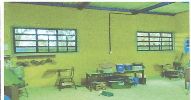
Foto 2. AULA 2 VENTANAS NUEVAS INSTALADAS
