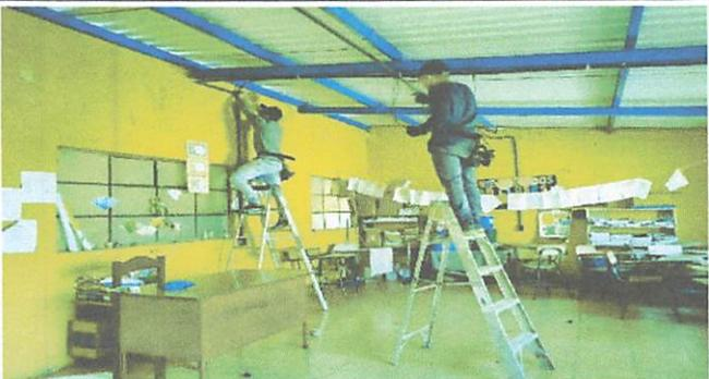
Foto 3: INSTALACION DE DUCTOS ELECTRICOS EN AULAS
