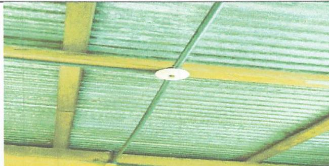
Foto 5: DUCTOS Y PLAFONERAS YA INSTALADAS
