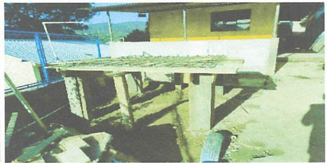
Foto 2: CONSTRUCCION DE BASE PARA DEPOSITO
