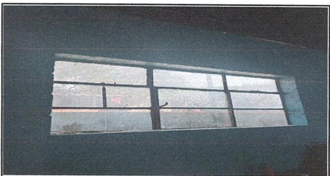
Foto 6: AULA 2 SE CAMBIA EL MACHIMBRE POR CIELO FALSO
