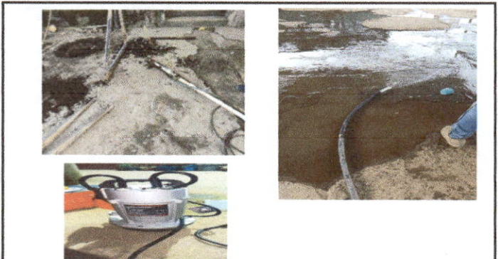
Foto 2: Limpieza y ampliación pozo No. 2 y cambio de bomba
