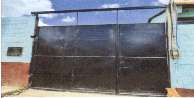
Foto1: Reparacion de portón
