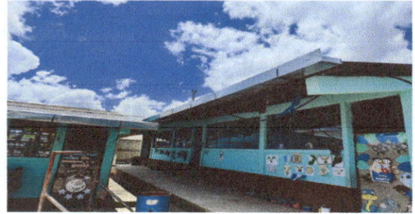
Foto 2: Intalacion de canales para agua pluvial
