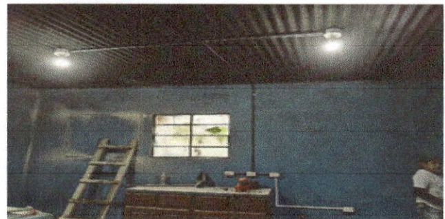
Foto 6: Ampliación de ventanales y de energía eléctrica
