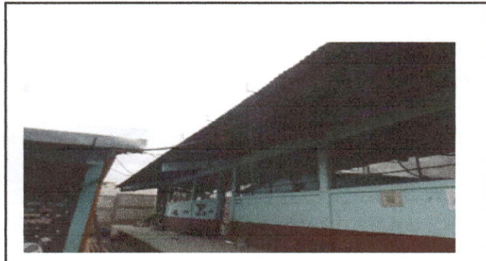
Foto 2: Intalacion de canales para agua pluvial
