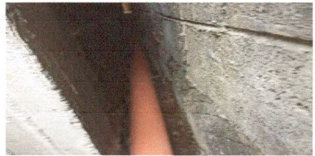
Foto 4: Reparación muro de contención, introducción tubería para evitar futuro socabamiento
