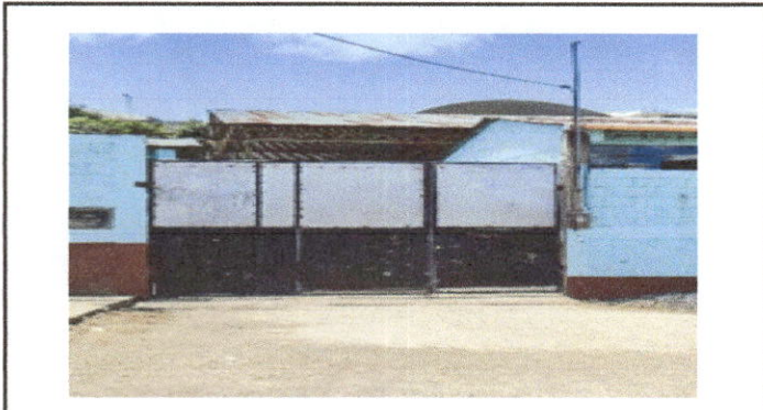
Foto 1: Reparacion de portón
