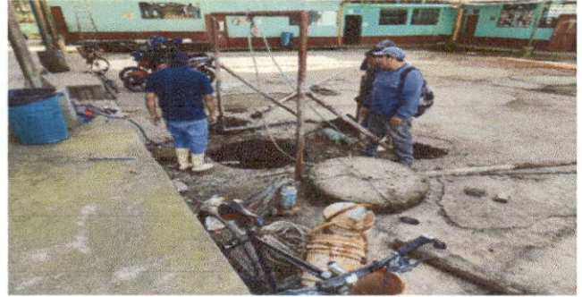
Foto 2: Limpieza y ampliación pozo No. 2
