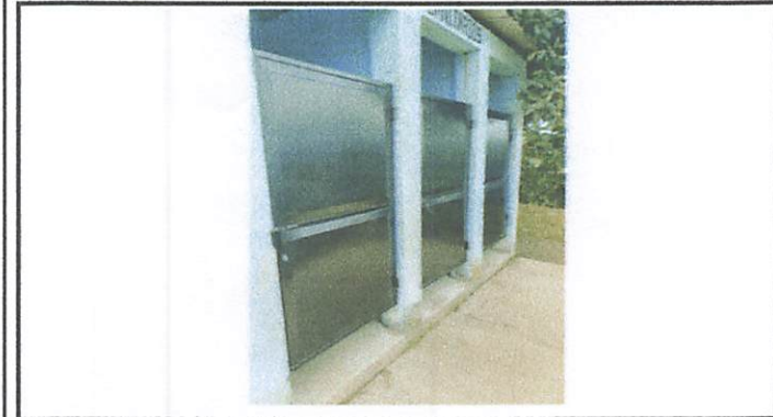
Foto 1: Reparación de puertas de sanitarios
