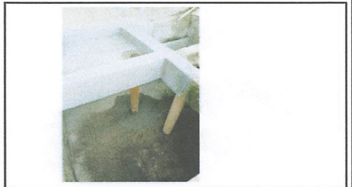
Foto 4: Reparación de lavadero y drenaje de pila
