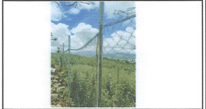
Foto 2: Reparación de malla perimetral
