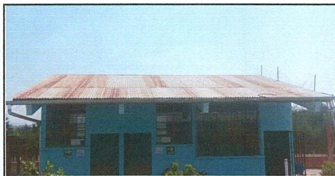
**Foto 5: SE PRETENDE EL CAMBIO COMPLETO DEL TECHADO DEL AREA DE SANITARIOS QUE YA ESTA EN MAL ESTADO. INCLUYE EL AREA DE LA DIRECCION.**
