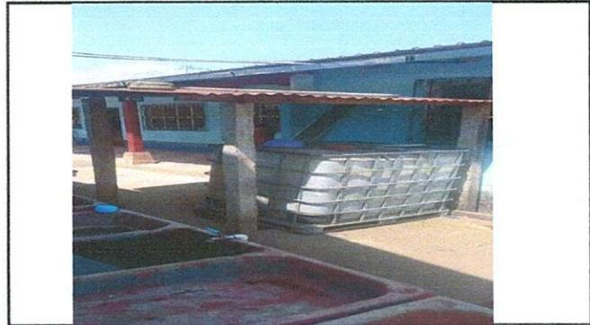
Foto 10: SE PRETENDE EN ESTA AREA LA CONSTRUCCION DE BASE DE CONCRETO DE 3 METROS DE ALTO PARA LA COLOCACION DE TINACO PARA ABASTECER DE AGUA A LAS PILAS Y CHORROS.
