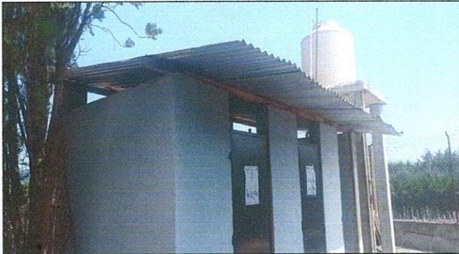
Foto 7: SE PRETENDE EL CAMBIO DEL TECHADO DEL AREA DE SANITARIOS, COLOCACION DE COSTANERAS DE METAL Y LAMINA TROQUELADA.
