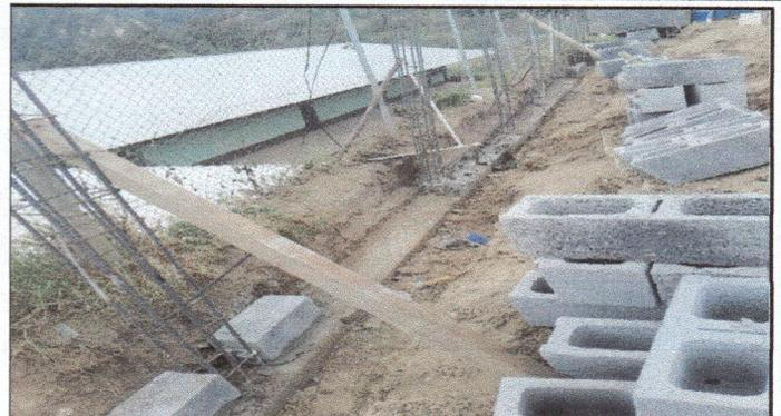
Foto 2: Las bases ya colocadas listas para colocar las paredes.
