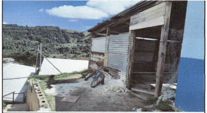
Foto 2: parte frontal en donde estará la puerta de la cocina.
