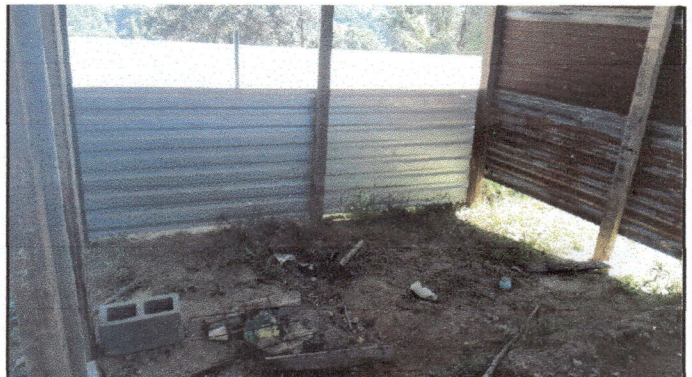
Foto 4: Espacio de ampliacion de la cocina.
