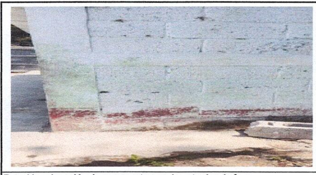
Foto 11: colocación de una puerta para la entrada a la fosa
