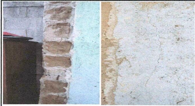
Foto 1: Cambio de pared de la cocina
