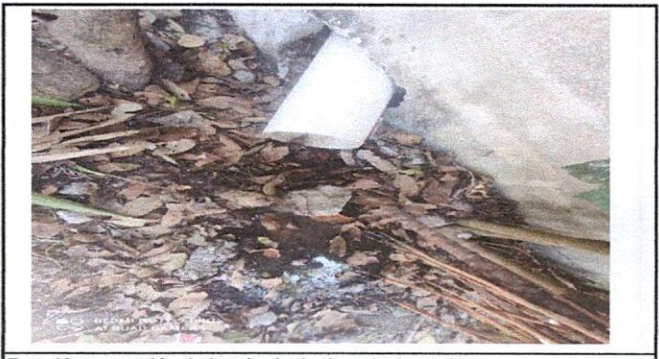
Foto 12: reparación de la tubería de drenaje de cocina
