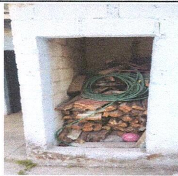
Foto 2: Reparación de la bodega de cocina
