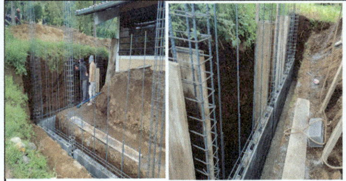
Foto 2: Muro de contención.
