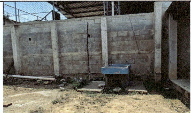
Foto 6: cambio de pila y techado
