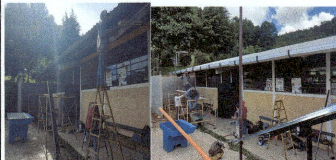
Foto 5: cambio de canales y bajadas.
