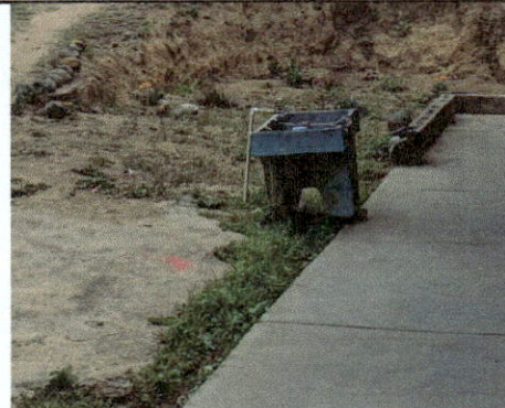
Foto 4: cambio de pila y techado.
