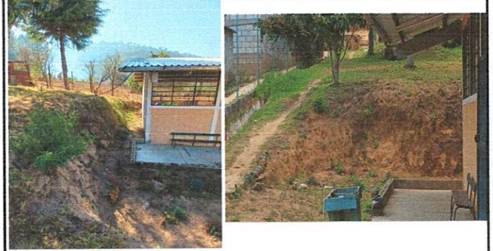
Foto 2: Muro de contención.
