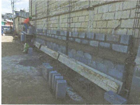
Foto1: Colocación de block en el muro perimetral.
