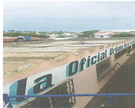
Foto 4: vista de las aulas, despues de la destechada.
