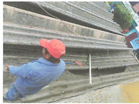
Foto 2: Desmontada de Techo.
