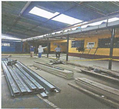
Foto 3: Corredor y materiales a armar.
