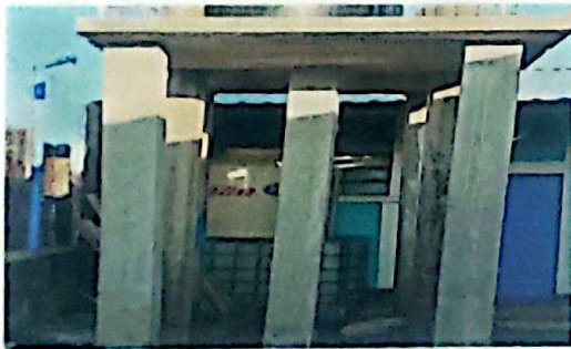
Foto 3: finalización de la base para el tinaco
