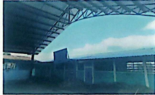
Foto 2: finalización del cambio de láminas de la dirección, 3 aulas y baños para hombres y mujeres
