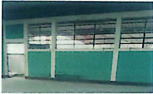
Foto 1: Finalización de corona de la dirección, 3 aulas y baños para hombres y mujeres
