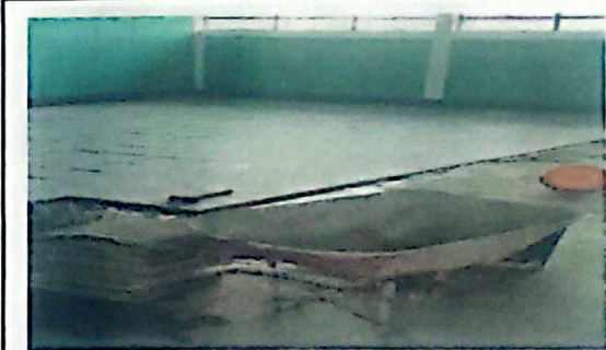
Foto 4: cambio de piso
