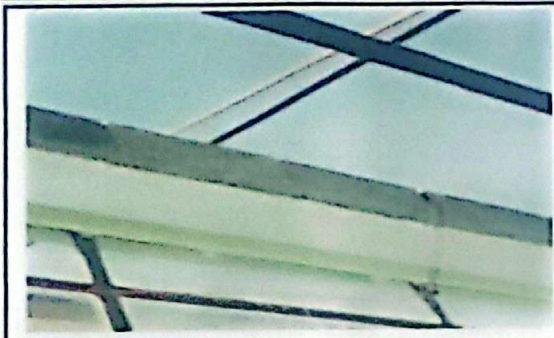
Foto 1: SUSTITUCION DE de adobe por block
