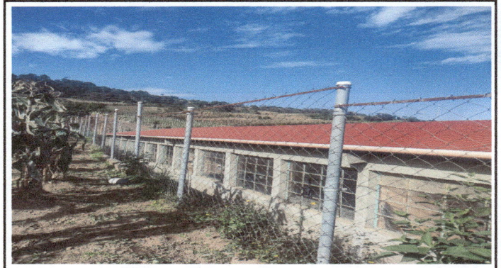
Foto 4: Sustitución de lamina por deterioro y filtración de agua y costanera.
