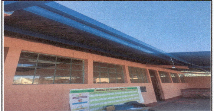
Foto 2: Sustitución de lamina por deterioro y filtración de agua y costanera.
