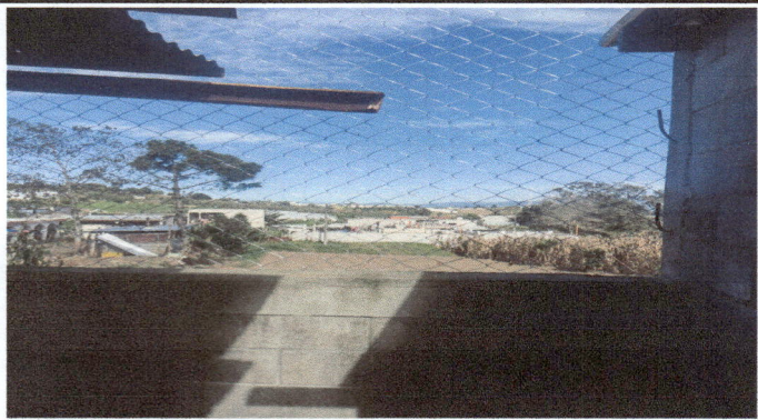
Foto 3: Sustitución de mallas por deterioro.
