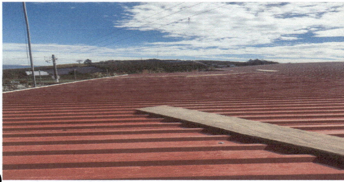
Foto1: Sustitución de lamina por deterioro y filtración de agua y costanera.
