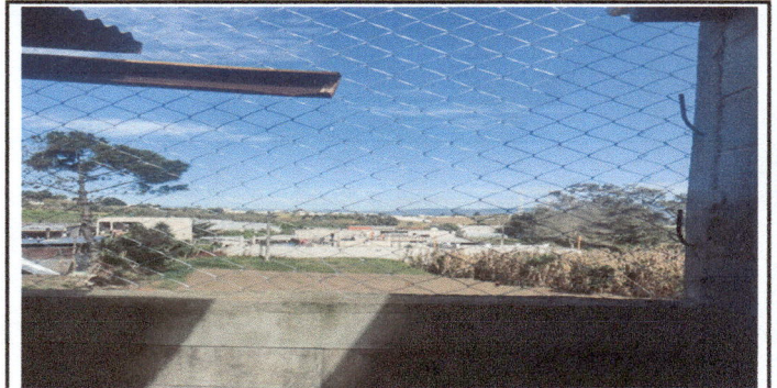
Foto 6: Sustitución de mallas por deterioro.
