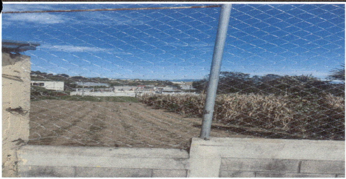
Foto 5: Sustitución de mallas por deterioro.
